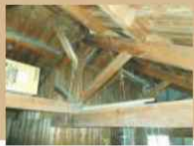
▲蔵側の2階小屋トラス
