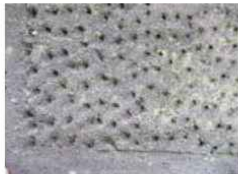
写真③ 軟石表面の小叩き仕上げ ノミのようなもので叩いて凹凸を付けています。
