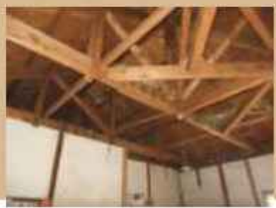
▲店舗側の2階小屋トラス
