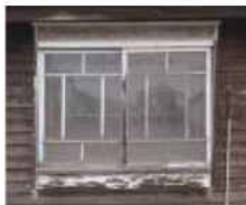
◀1 階の引き違い窓
