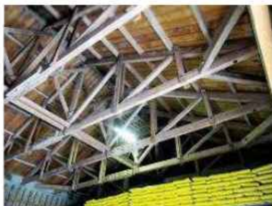
▲農業倉庫の内部の様子 小屋組はキングポストトラス
