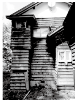
下見板の脱落 軒の変形
